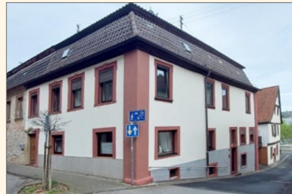
West- und Südfassade
