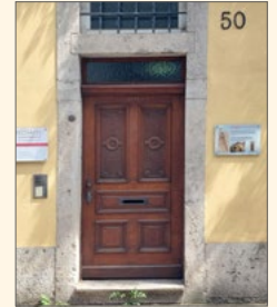
Türblatt u. Portal (bauzeitlich)
