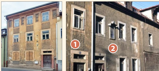
Aufnahme 2024 Türstock 1844 1 – Zustand vor dem Umbau des nördl. Teils 2
