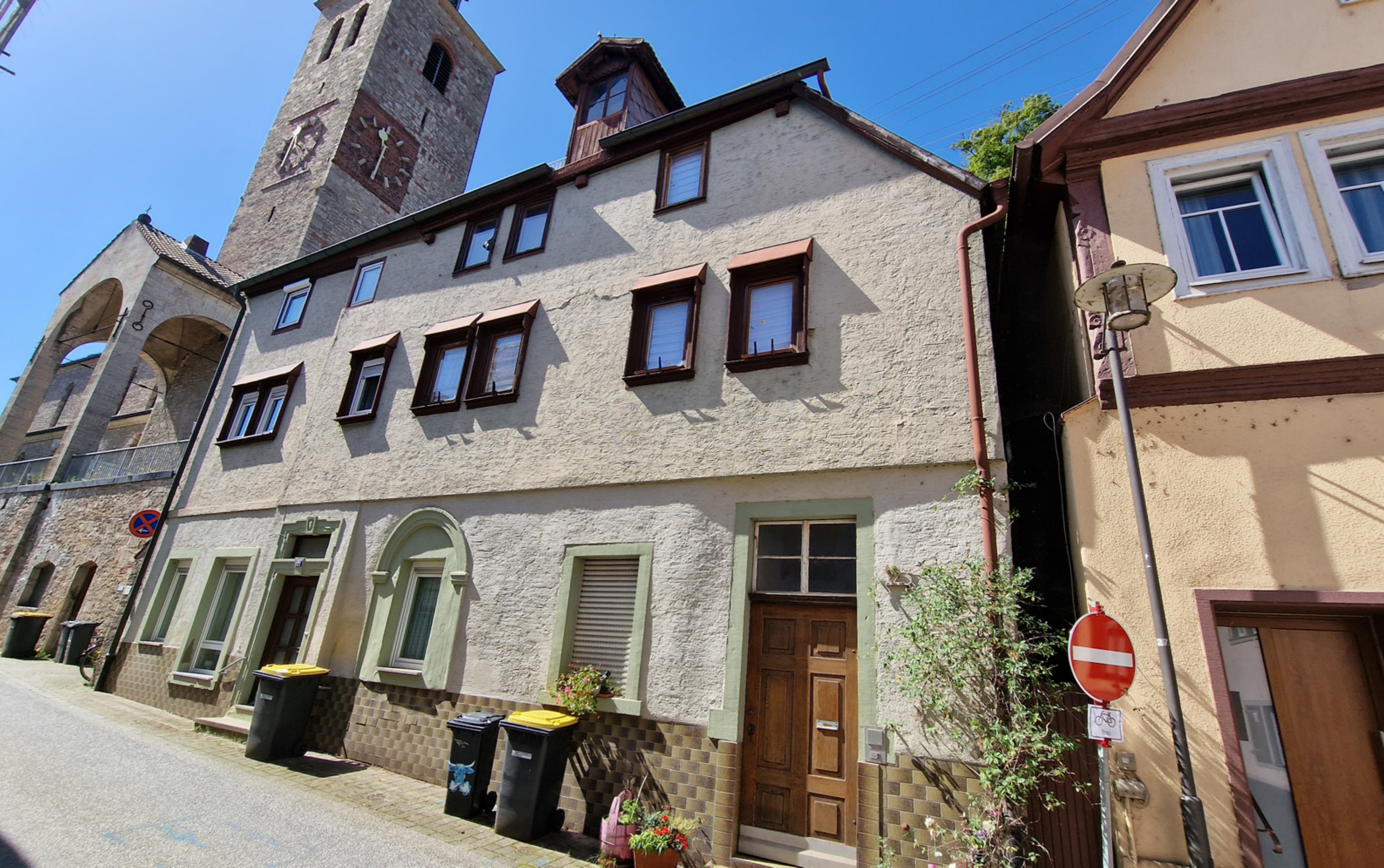
Hauptstraße 121 und 123; im Kern 17. Jh. und im 18. Jh. stark verändert, u.a. bei Nr. 123 der ursprünglich giebelständige Dachstuhl teilweise abgetragen und nördlich ein Satteldach angesetzt, welches sich auch über Nr. 121 erstreckt und beide Baukörper unter einem Dach zusammenfasst. Der Bau erscheint somit heute weitgehend traufständig (erhaltenswertes, ortsbildprägendes Gebäude). © transform
