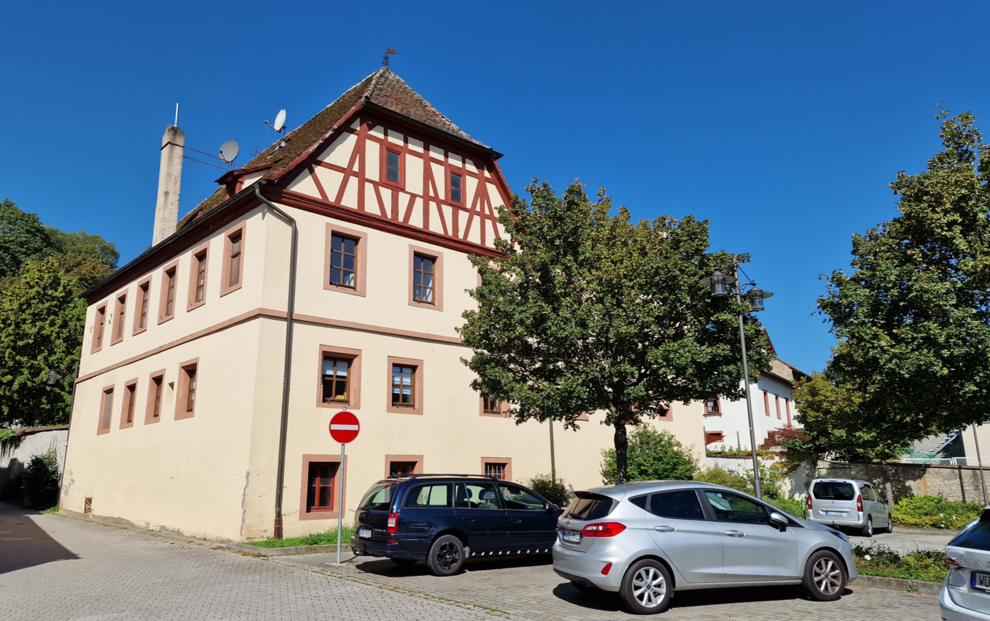
Wendeplatz 1, sog. Pfaffsmühle
