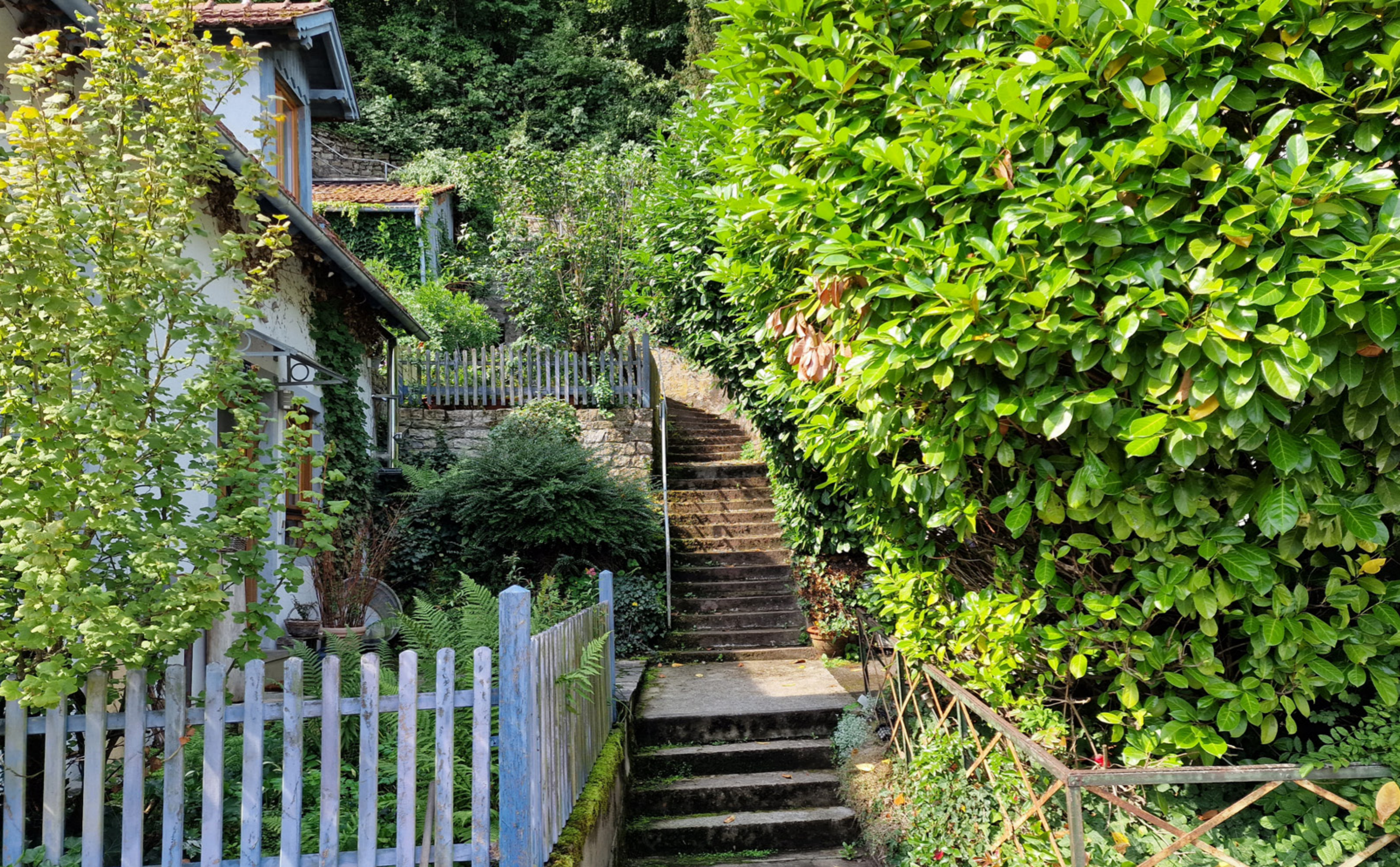
Stiegen und Pfade im westlichen Alort: Erschließung der alten Wirtschaftsflächen am Zeller Berg und der rückwärtigen Bebauung „in zweiter Reihe“, hier Bereich Hauptstraße 77.
