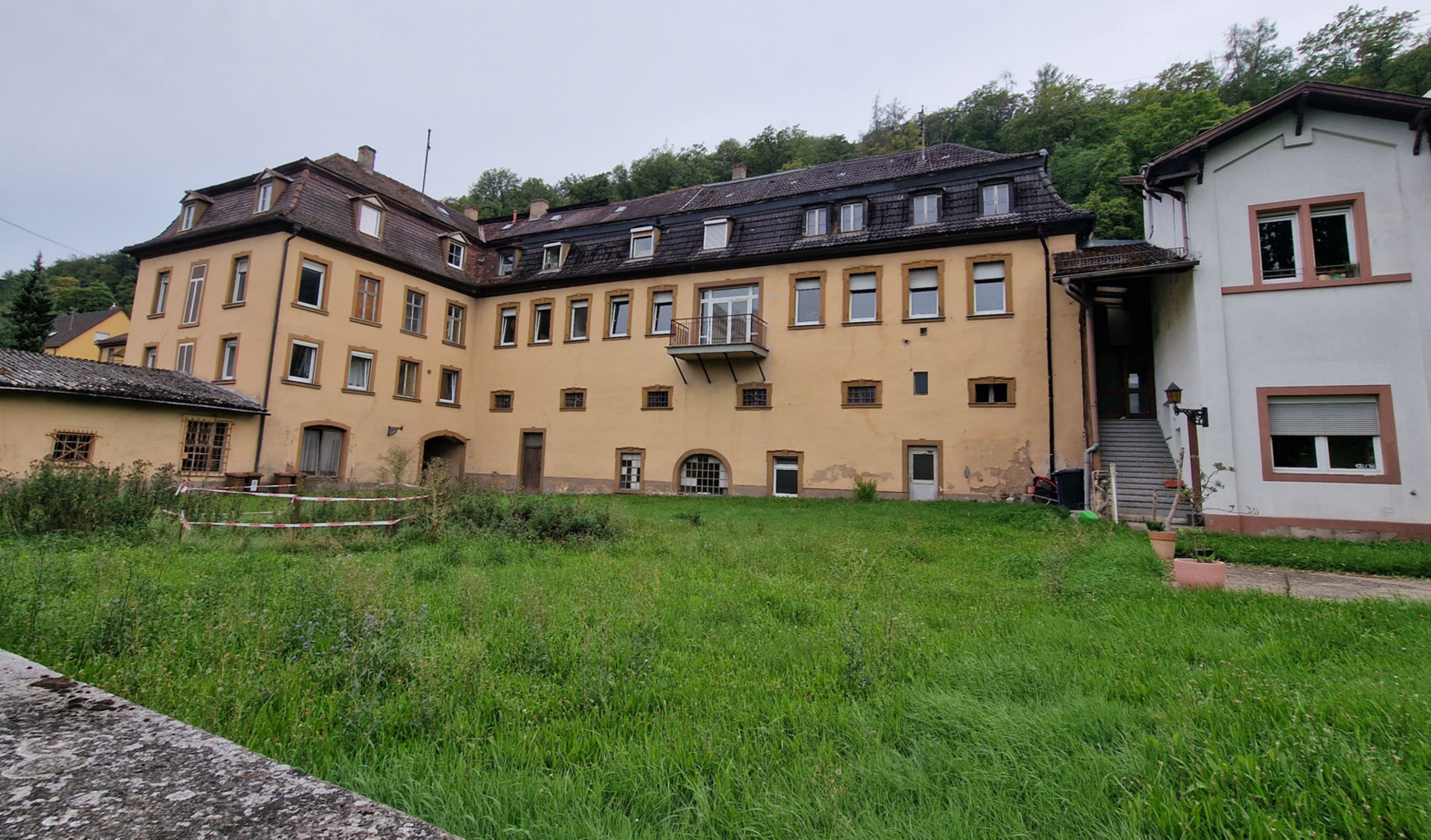
Ehem. oberes und mittleres Plateau des barocken Terrassengartens des Zeller Schlosses. Die historischen Strukturen verbergen sich unter massiven Auffüllungen, die im Zuge der Anlage der Umgehungsstraße und der Mainuferstraße in den 1960er Jahren entstanden. © transform
