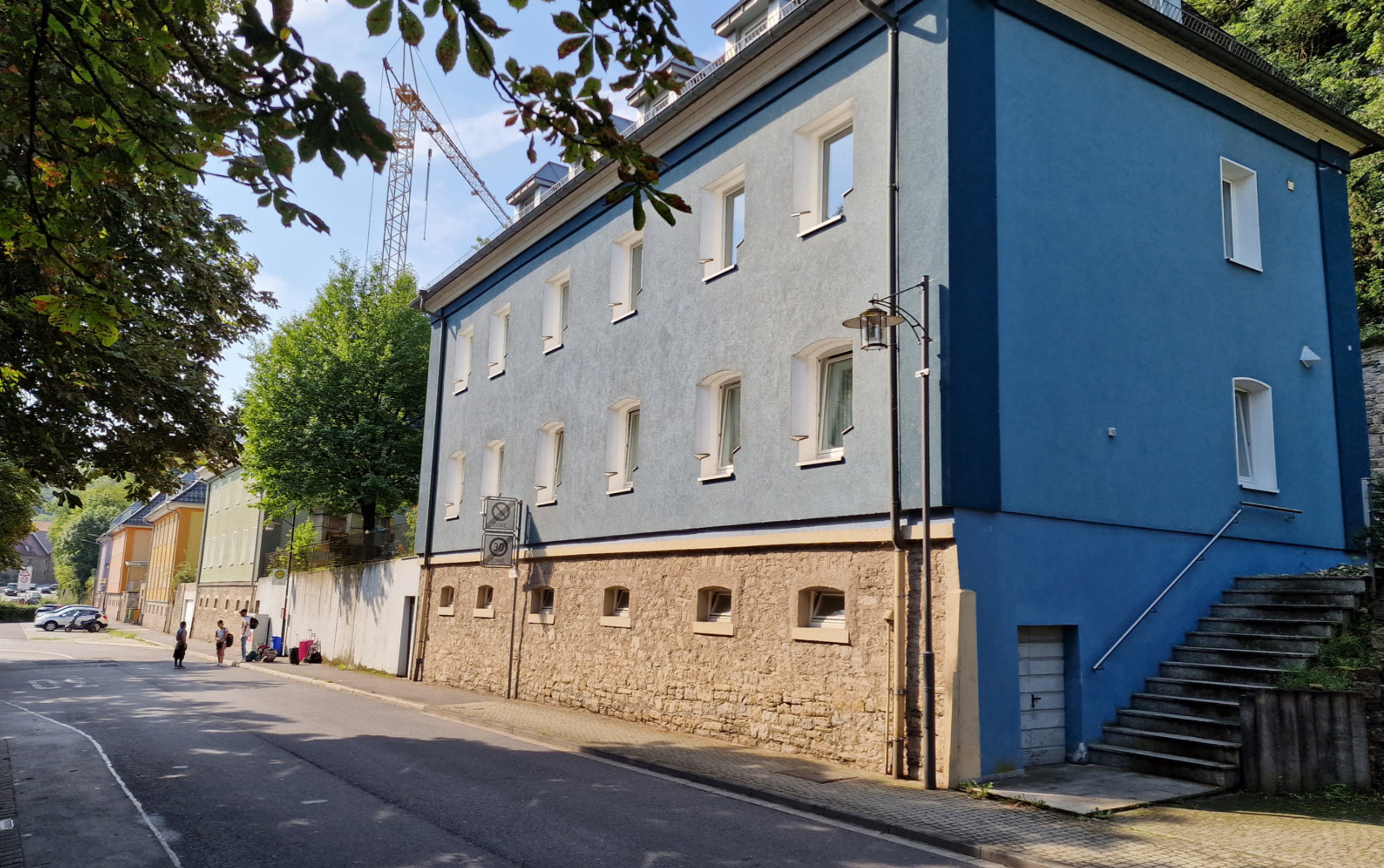
Sog. Fabrikhäuser, um 1869 erbaut von König&Bauer als Arbeitersiedlung.
