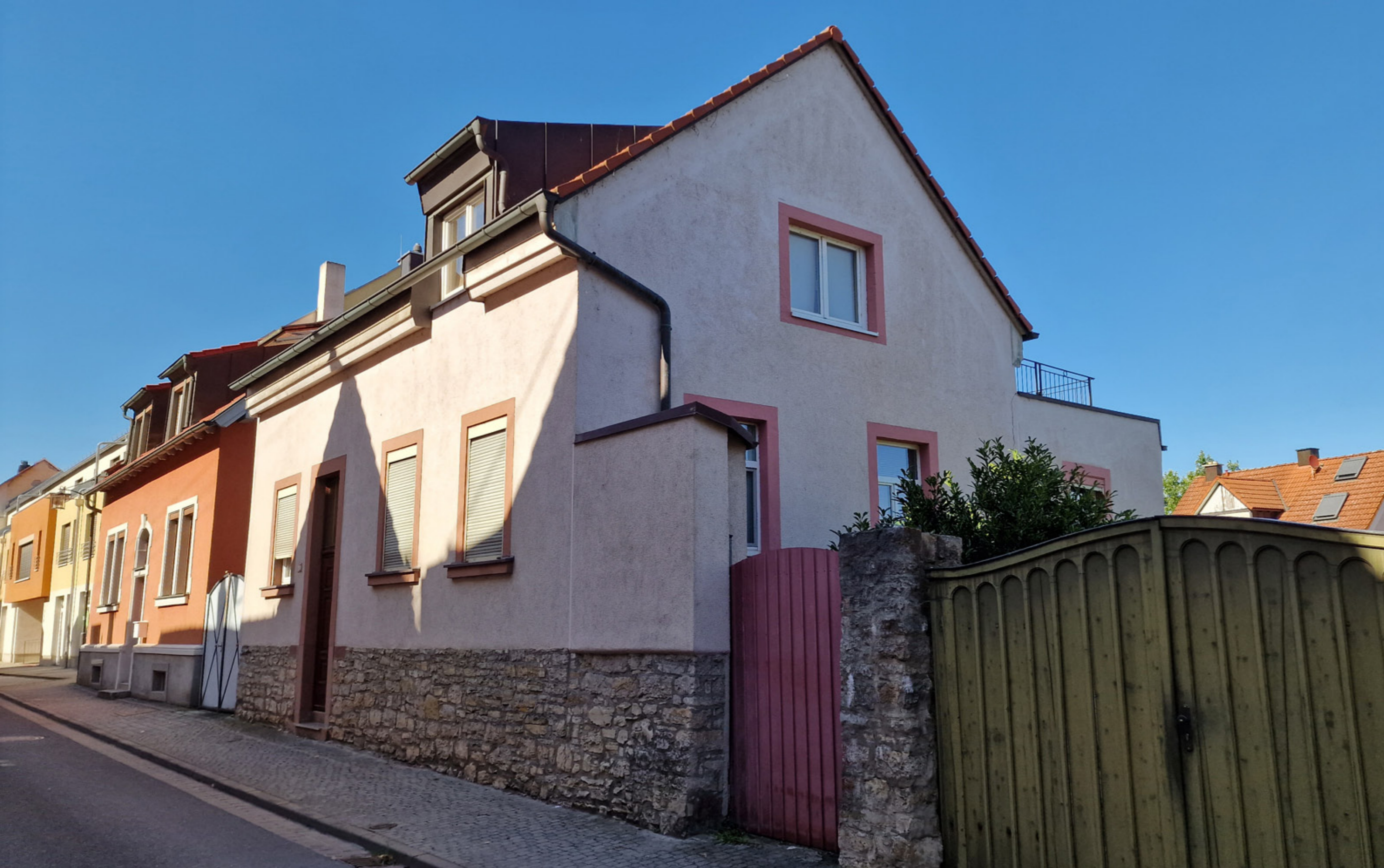
Hauptstraße 110 und 114, Zeitgenössische Bebauung auf der alten Klostermauer, Ende 19./Anfang 20. Jh.
